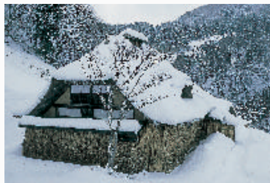
湯殿山の麓、朝日村田麦侯の多層民家。山村豪雪地ならではの、兜造りと呼ばれる豪壮な茅葺き屋根が優美だ。
