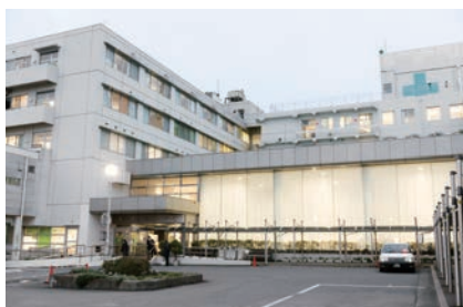
茨城県取手市周辺地域の中核病院として機能しているJAとりで総合医療センター。周辺には定年後の世代が多く暮らし、高齢化が進んでいる。
